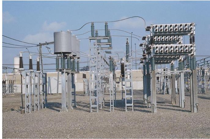
FIGURE 64 – Gradins de condensateurs placés sur le réseau HTA (63 kV)
