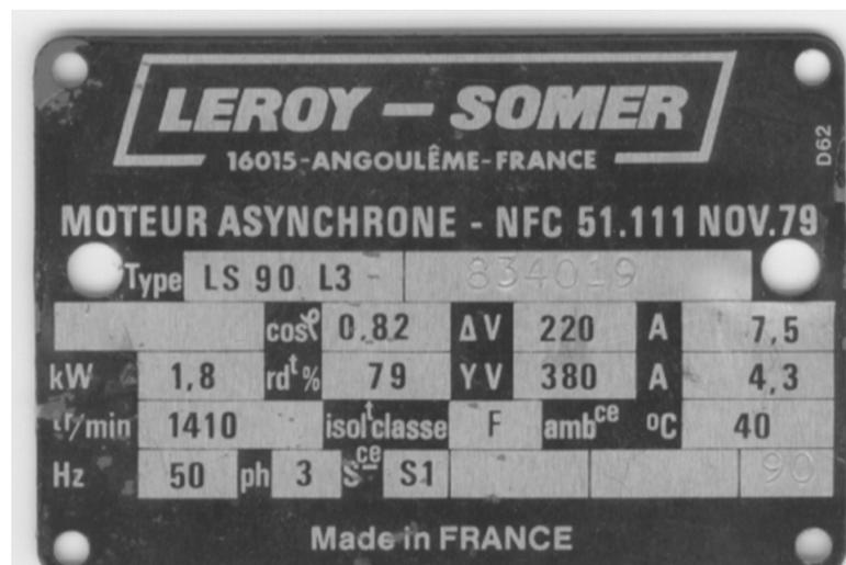
FIGURE 2.2 – Plaque signalétique d'une machine asynchrone.
